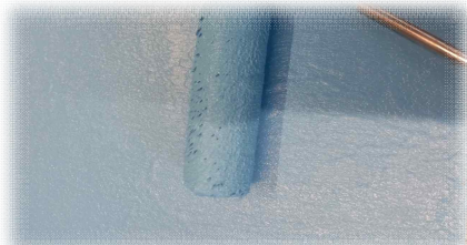
롤러를 이용한 방수재 도포
