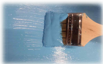
붓을 이용한 방수재 도포
